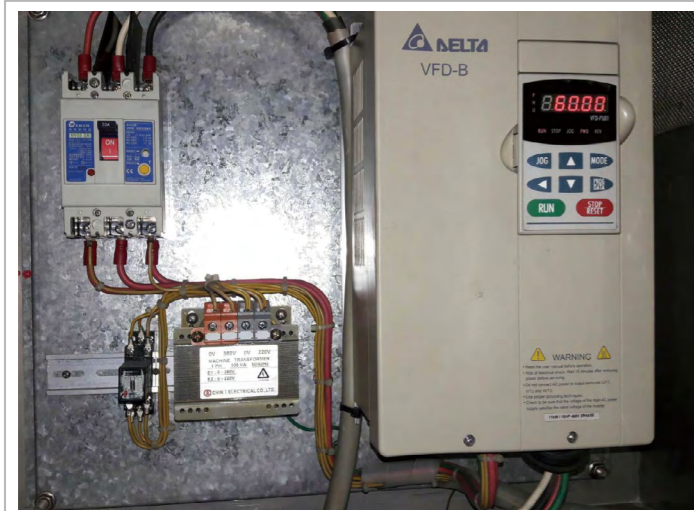
▲ 1 案 自來水泵浦利用變頻器調整適當用量
