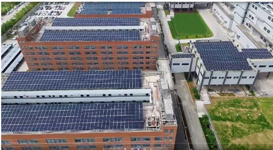
宿舍及連廊屋頂
